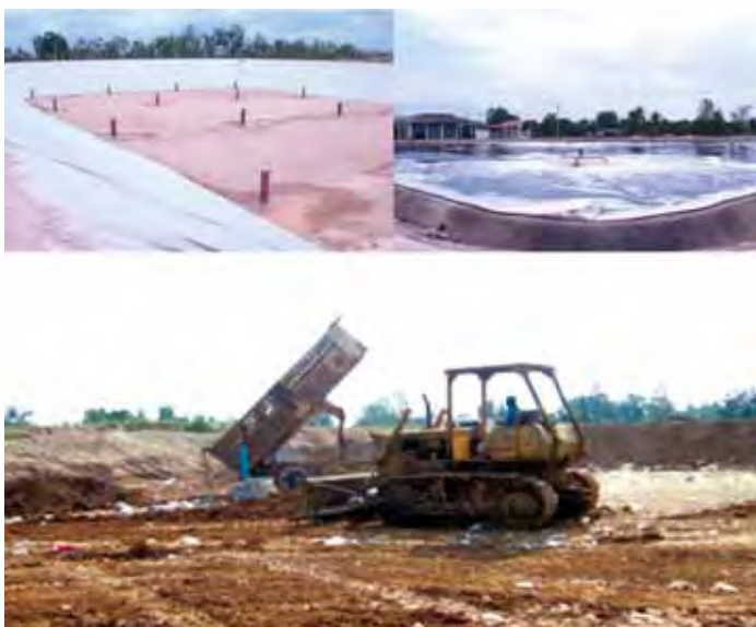
รูปที่ 4 ตัวอย่างการฝังกลบขยะมูลฝอยตามหลักสุขาภิบาล
